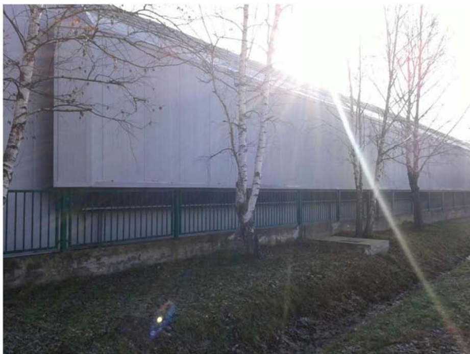
Slika 1 - Pogled na barijeru za zaštitu od buke
