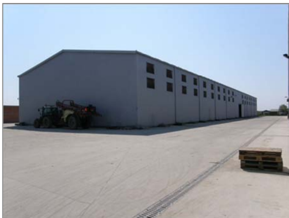
Slika 3. Hala box paletnog skladišta
