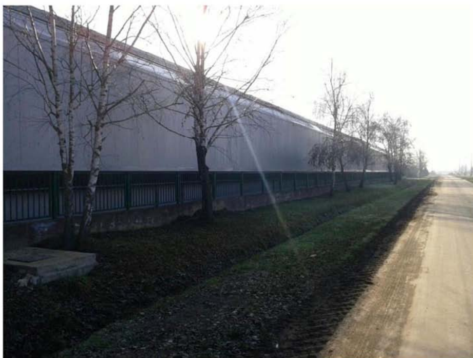
Slika 2 - Pogled na barijeru za zaštitu od buke
