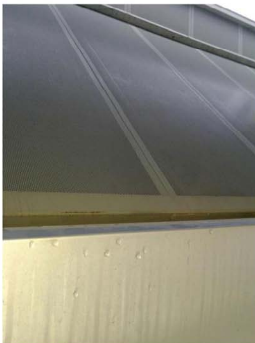
Slika 4 - Prikaz apsorpcijske strane barijere za zaštitu od buke
